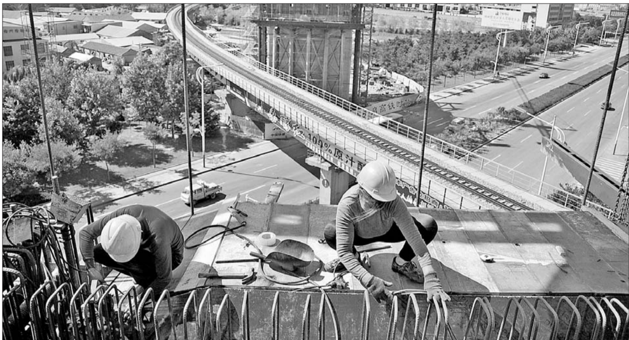
威海,建筑工人在铁路桥上施工。项目部工作人员介绍,桥梁每10天可以增长3-4米。 本报记者 王震 摄
