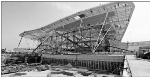
青岛铁路北客站正在建设中。 本报见习记者 杨广帅 摄
