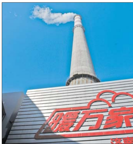
在浆水泉热源厂,经过层层除尘脱硫等工序,烟囱里排出的废气主要是水蒸气和二氧化碳,甚至比汽车尾气还干净。
