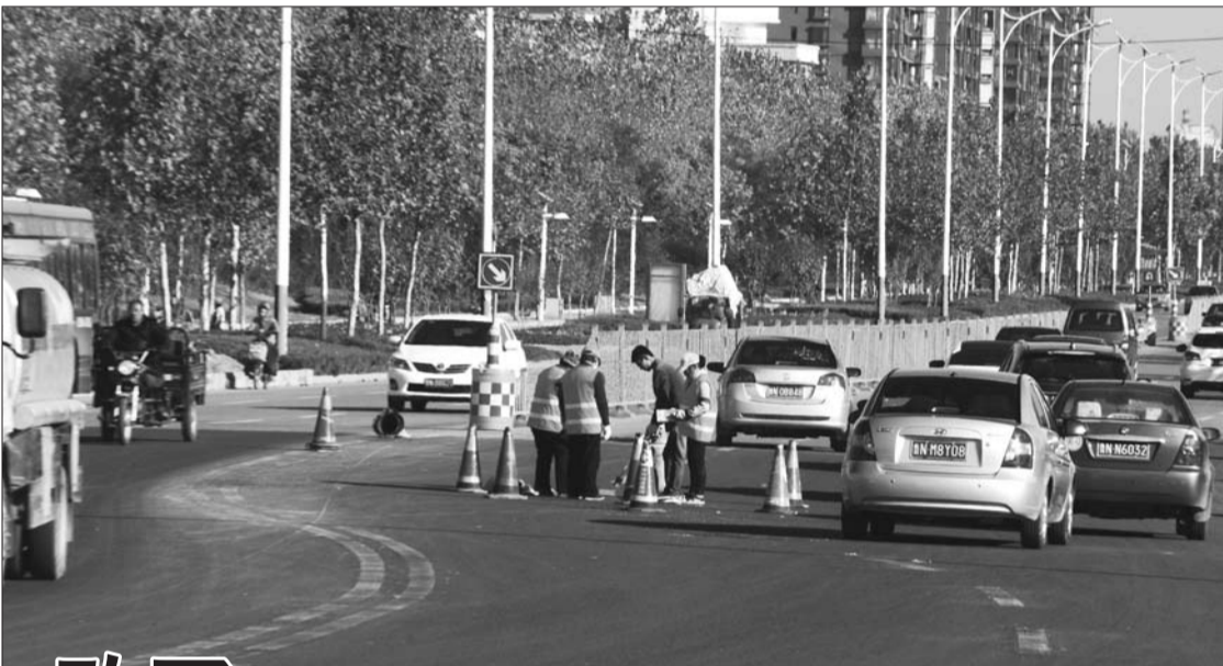
11月10日,在三八路岔河桥东侧,工作人员正在清除“S”形弯道处的交通标识线,准备进行改良。 本报记者 马志勇 摄
