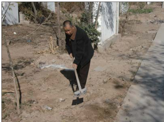
韩振林正在给公路路肩培土。
