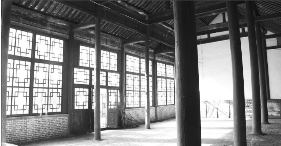
▲12根立柱牢牢支撑起房体。
