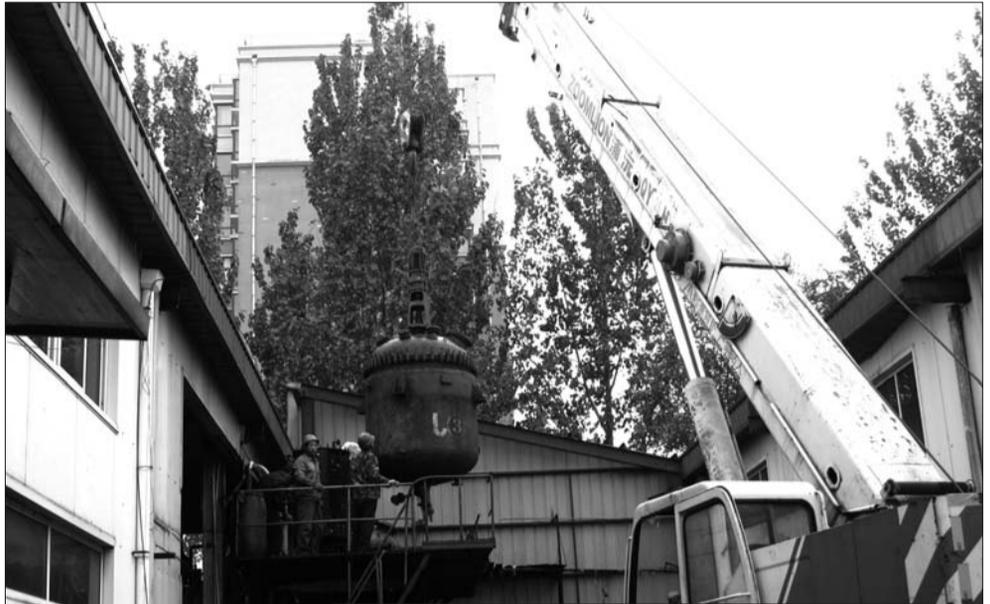
▲工作人员正将盛放反应单体的反应釜从操作平台吊出拆除。
