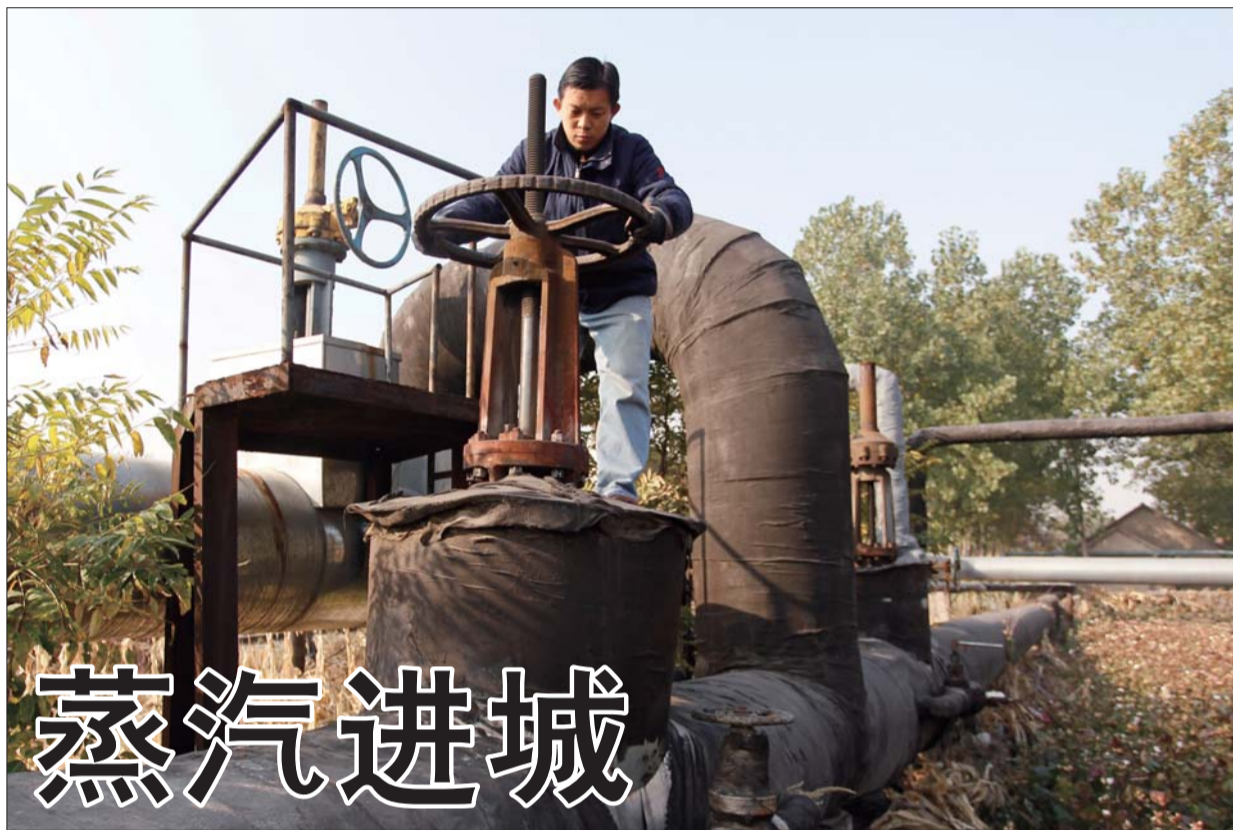
11日9时, 淄博环保热力公司的工作人员正在打开蒸汽管网北线阀门, 这是蒸汽通往张店城区的总阀门。预计经过一天时间的输送后, 蒸汽可到达该公司城区各换热站, 供暖可以随时启动。 本报记者 王鑫 摄影报道
