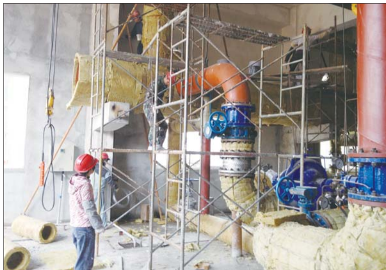
供热首站目前正在进行循环打压。 本报记者 李泳君 摄
