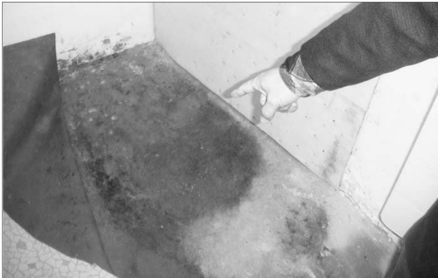
▲直到一户业主发现地面渗出了水,大家才发现水管破漏严重。
