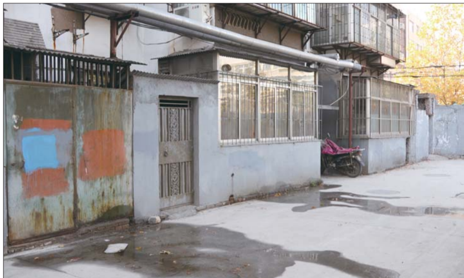
二毛社区西区4号楼前地面上的积水天冷结冰后存在很大安全隐患。 本报记者 王鑫 摄
