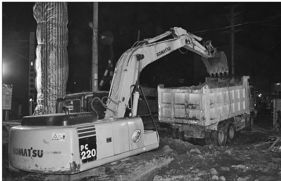
施工现场。本报通讯员 曹建明 摄
