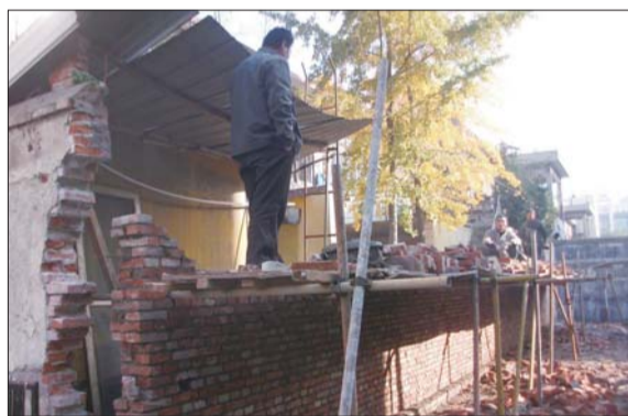
施工方正在恢复小区院墙。本报记者 甘倩茹 摄
