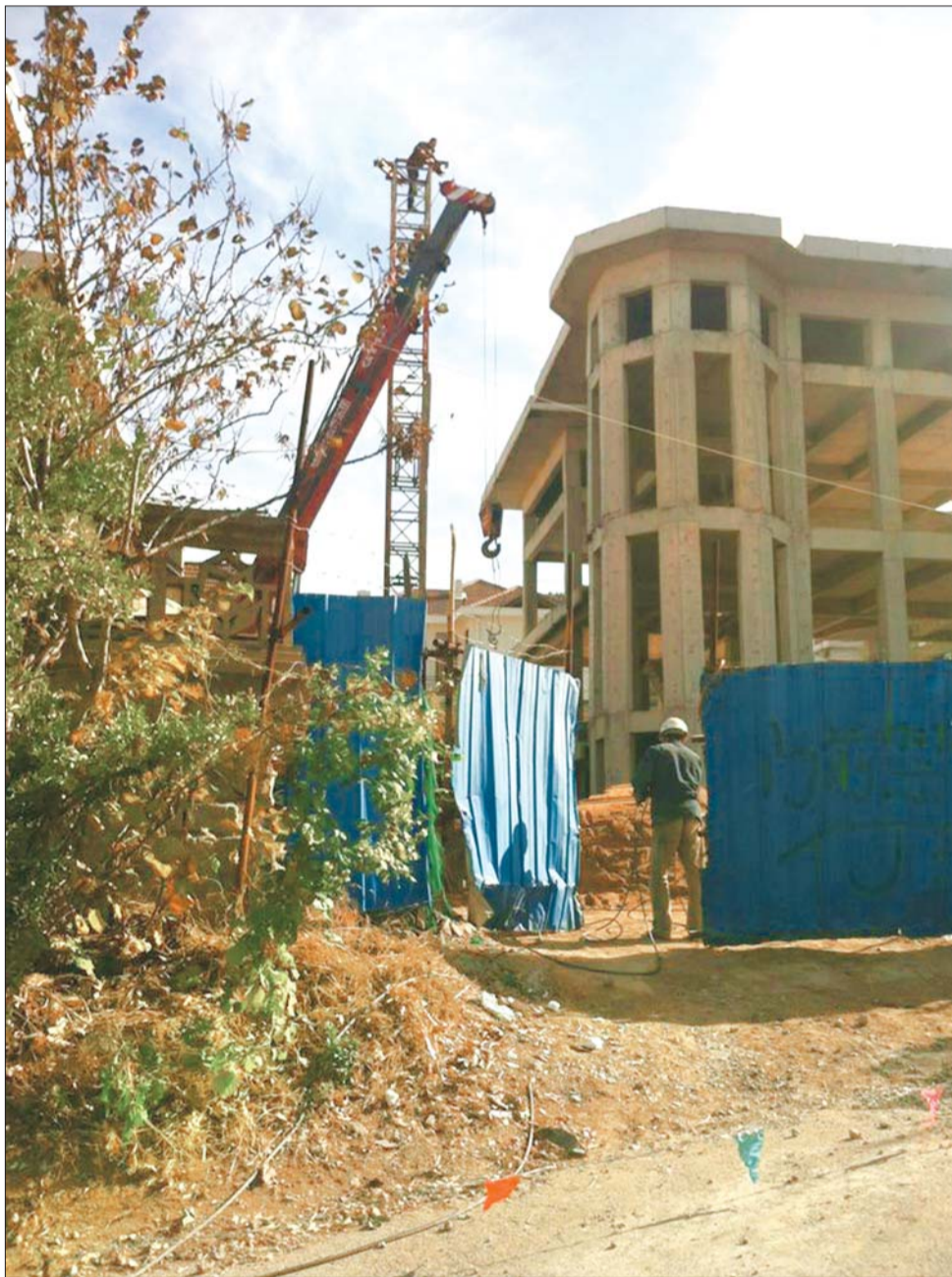
芝罘区迎山路违建别墅近日重新动工,图为13日,工作人员正在现场施工。 本报记者 李泊静 摄
