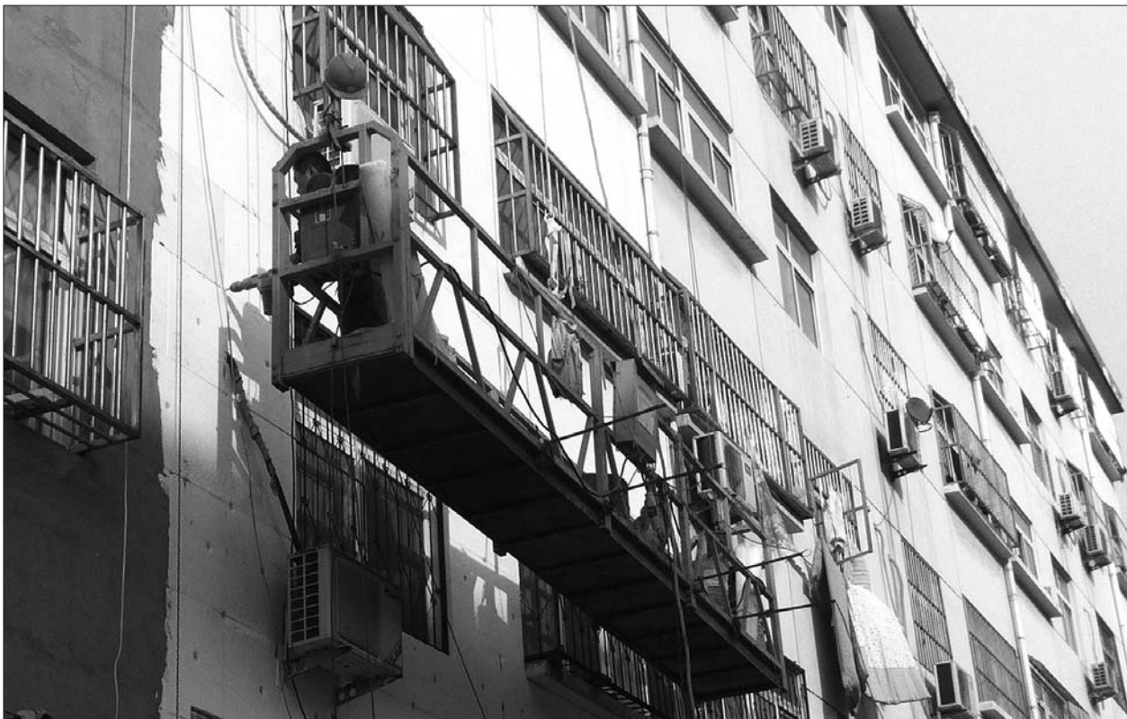
►滨河花园小区二期正在建筑节能改造。 本报记者 张召旭 摄
