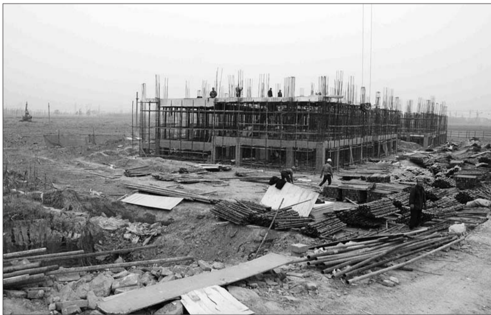
全市首个大规模养老地产项目——千岛山庄生态疗养示范基地施工现场。
