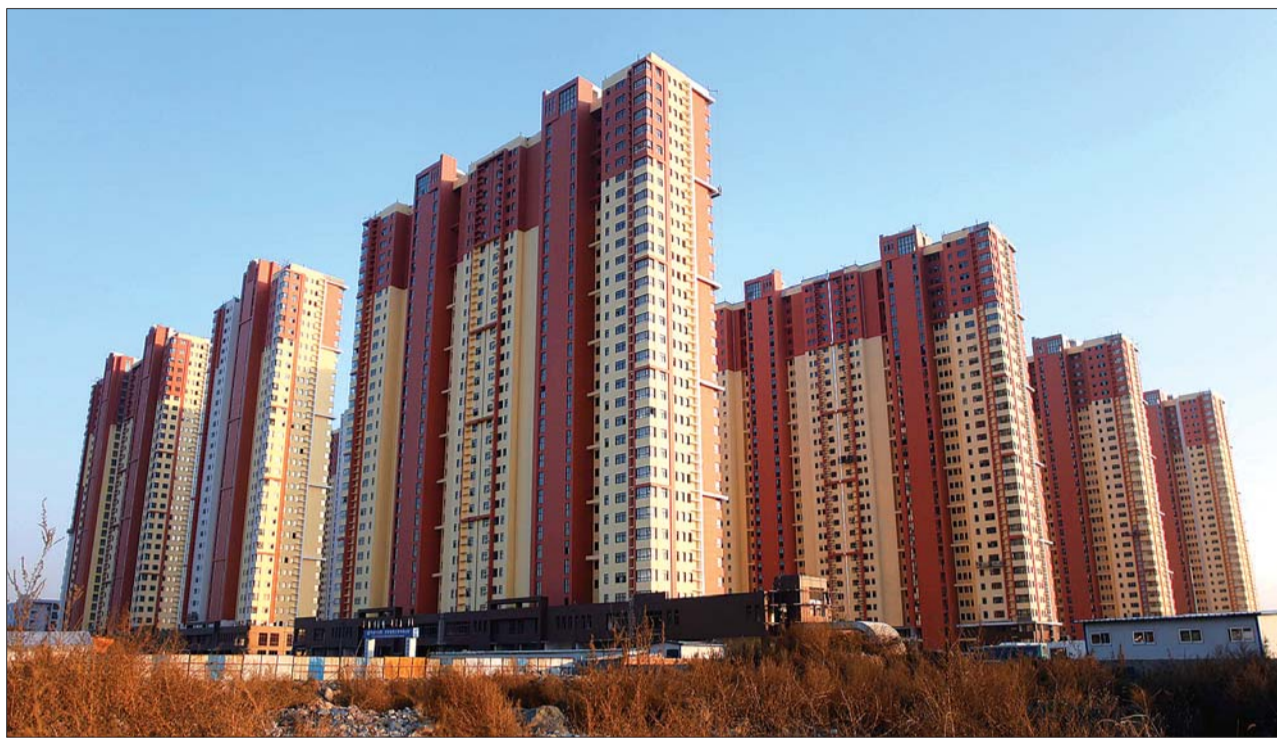
建设中的清雅居公租房,明年底交付使用。 本报记者 王鸿光 摄
