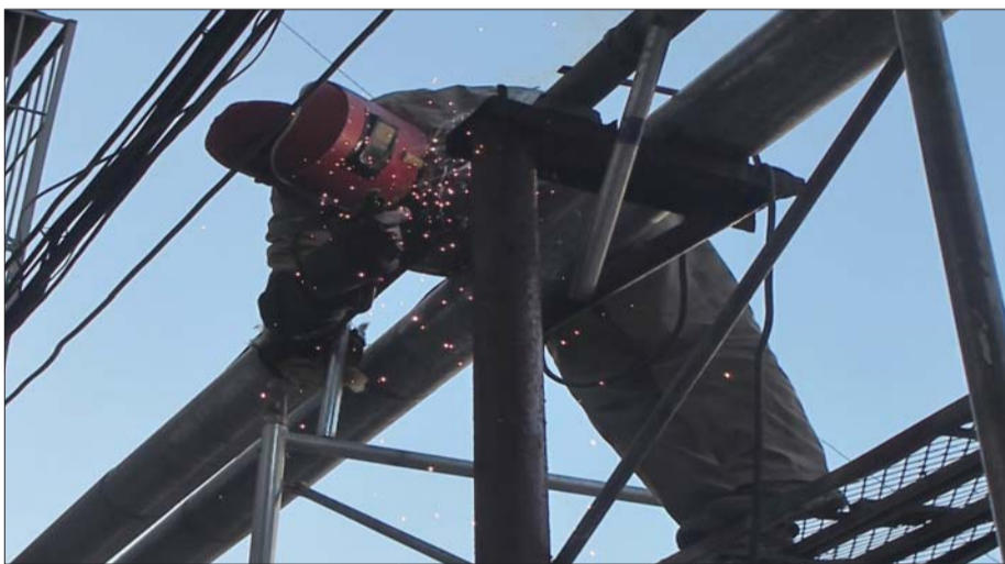
维修人员正在焊接漏水管。本报记者 张汝树 摄
