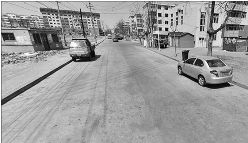
爆燃事故发生前的青岛市黄岛区斋堂岛街。
