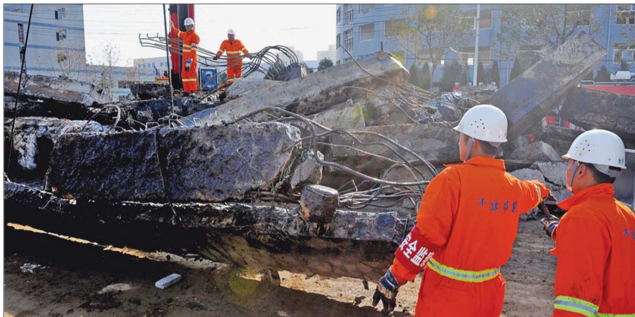
26日,工人在吊装清理出来的混凝土构件。东黄输油管线泄漏爆炸事故现场清理已接近尾声。 新华社发
