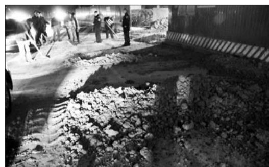
工人正在清理渣土车洒下的渣土。本报记者 李岩松 摄
