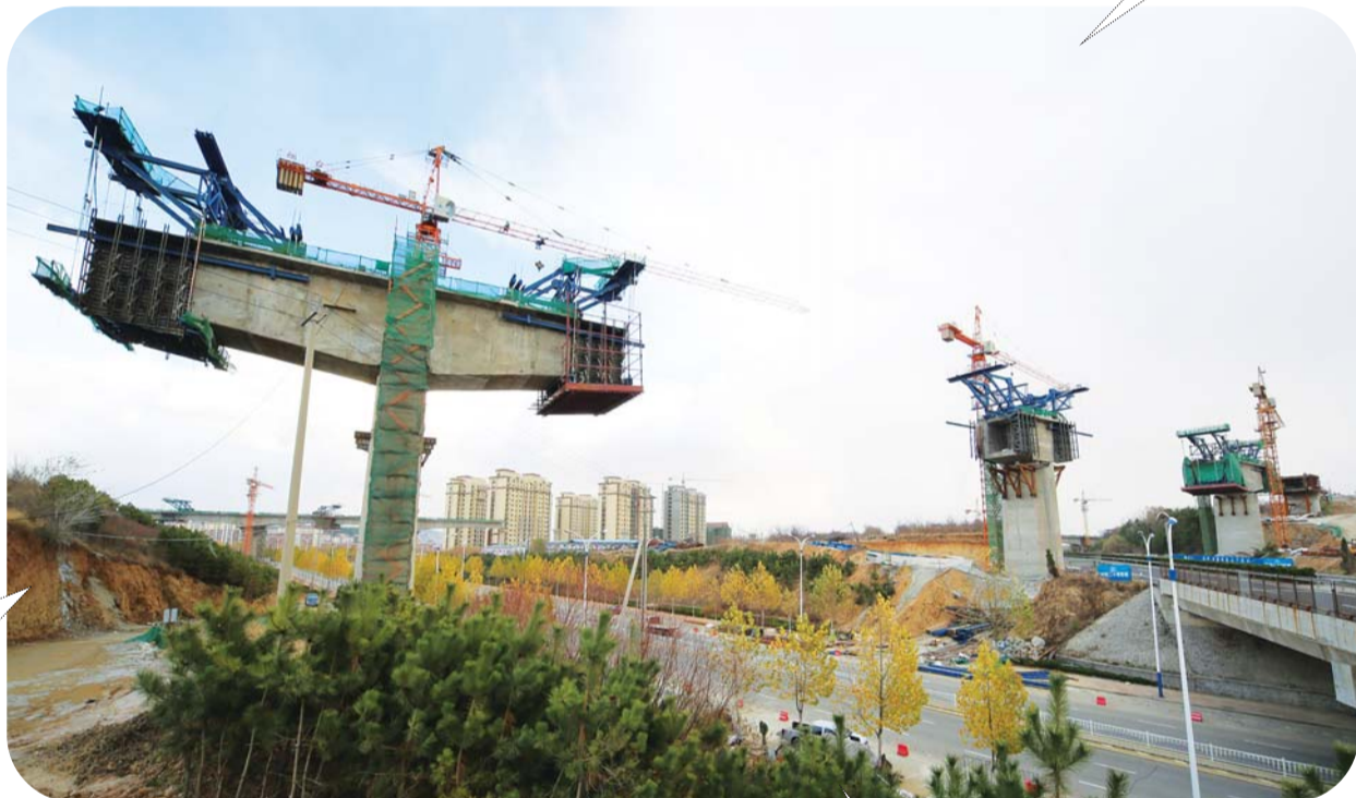
青荣城铁正在紧张建设中。 通讯员 张广洲 摄
