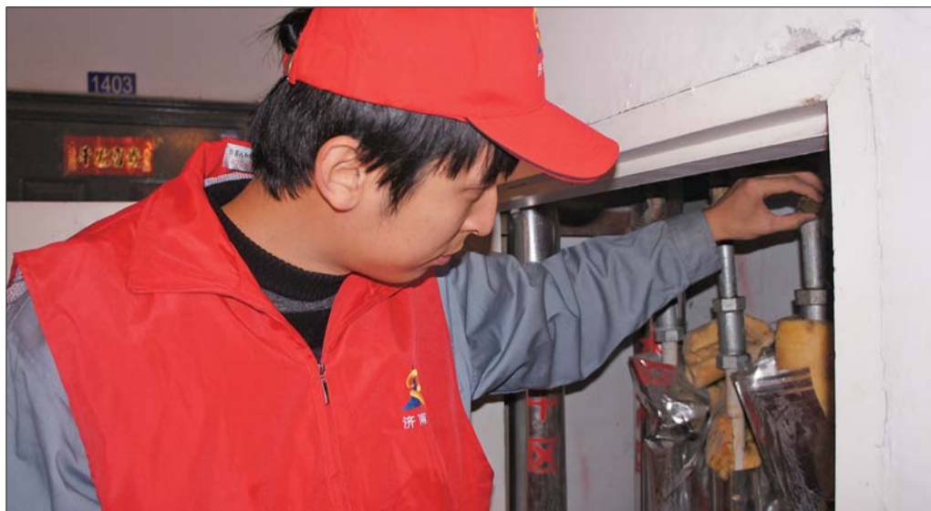
济南热力公司工作人员正在清洗居民家的过滤网。本报记者 蒋龙龙 摄
