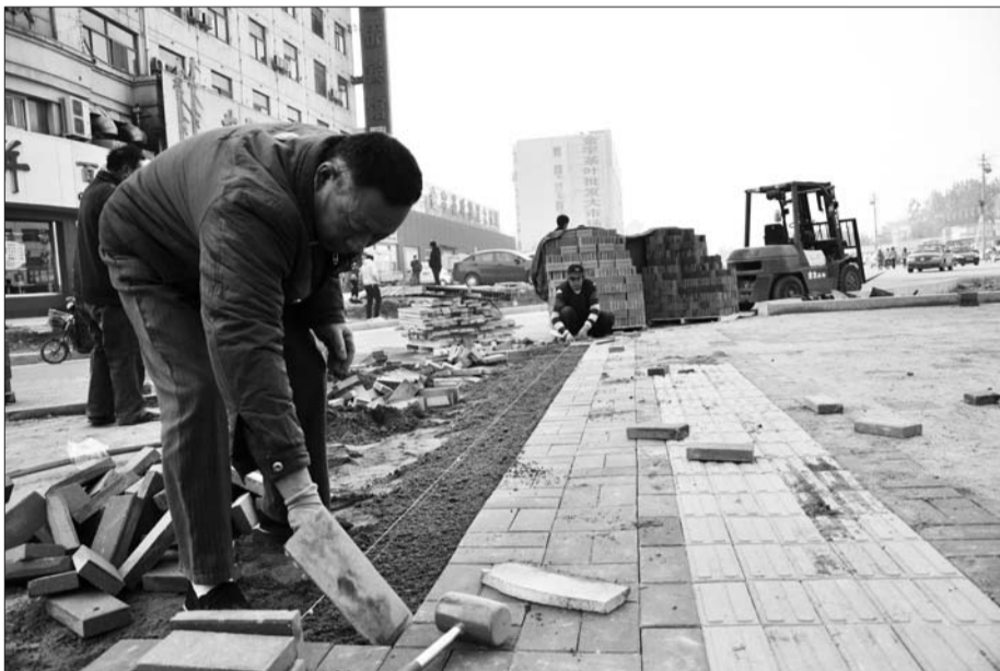
工人正在铺设人行道花砖。 公素云 摄
