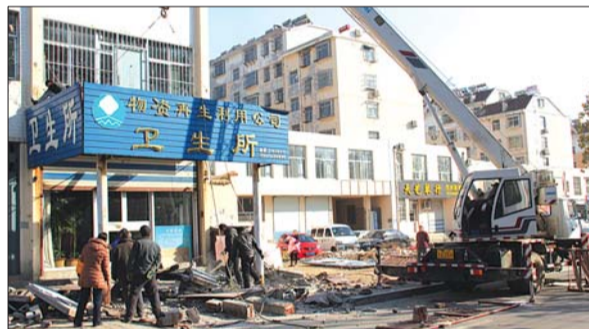
现场拆除钢混结构的违规搭建物。本报记者 张伟 摄 荣疗东路北、中、南三段同时展开。为减少业主损失,采取保护和再利用原则,尽量按照当事人要求进行拆除;当事人不在现场的,将铁皮屋、棚厦
