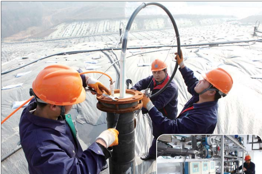
▲技术人员在安装沼气输送管线。
