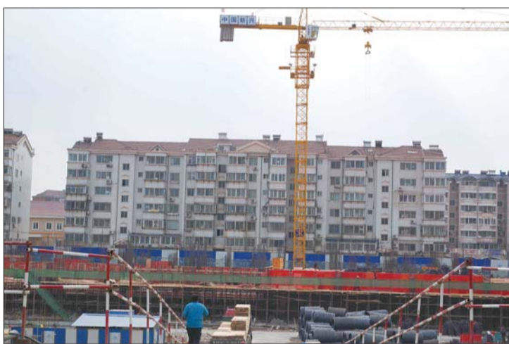
在星颐广场施工现场,工人还在做负一层施工建设。
