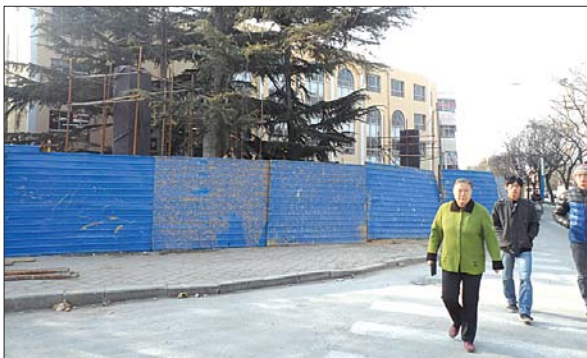
青年路便民通道施工现场竖起水泥立柱。本报记者 侯峰 摄
