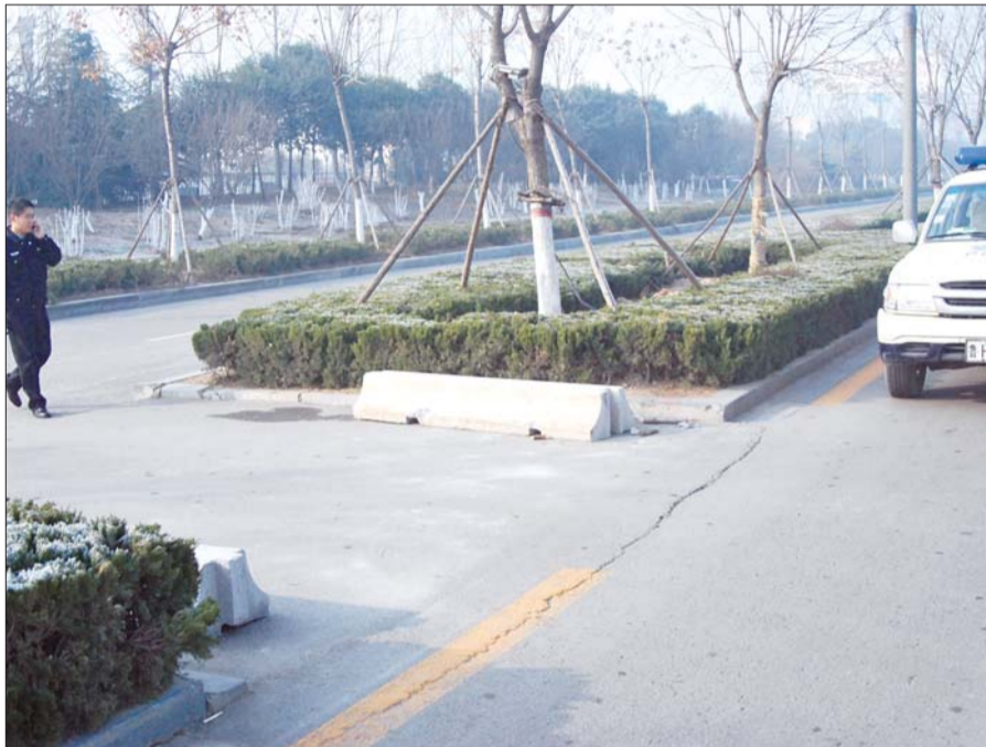
经过现场勘查,交警部门将路障清除。路帅 摄
