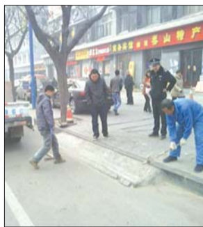
工作人员拆除水泥坡道。 本报通讯员 摄
