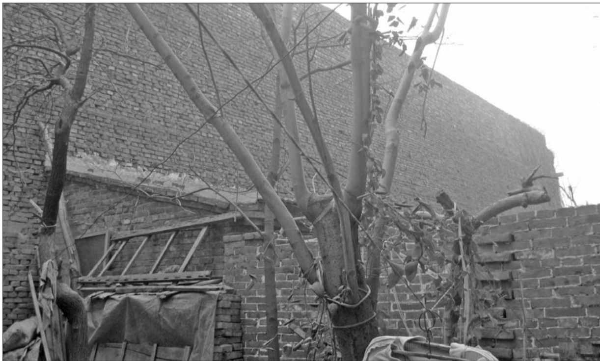
小区居民面临20余年的10米高墙。
