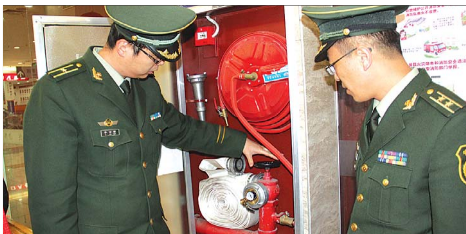
消防人员检测消防栓压力。 本报记者 张伟 摄
