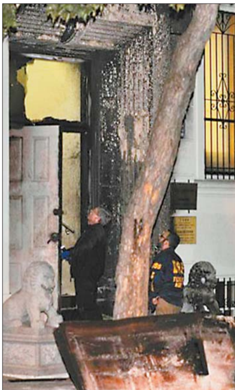
旧金山总领馆正门严重损毁。 据中新社
