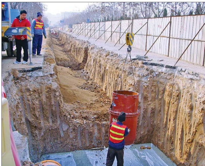
天辰路热力管道“汽改水”,让高新区变得更暖了。
