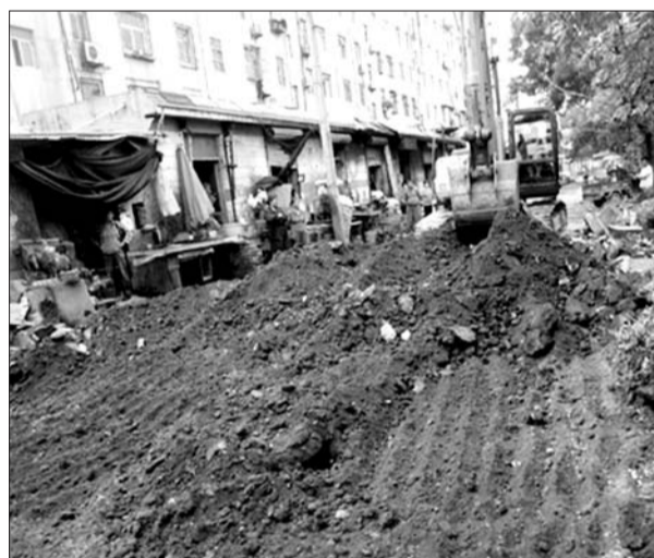
环城北路雨污分流改造施工现场(资料图)。
