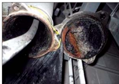
腐蚀老化的管道
