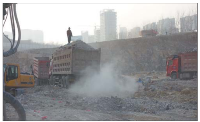
汉峪金谷施工现场。
