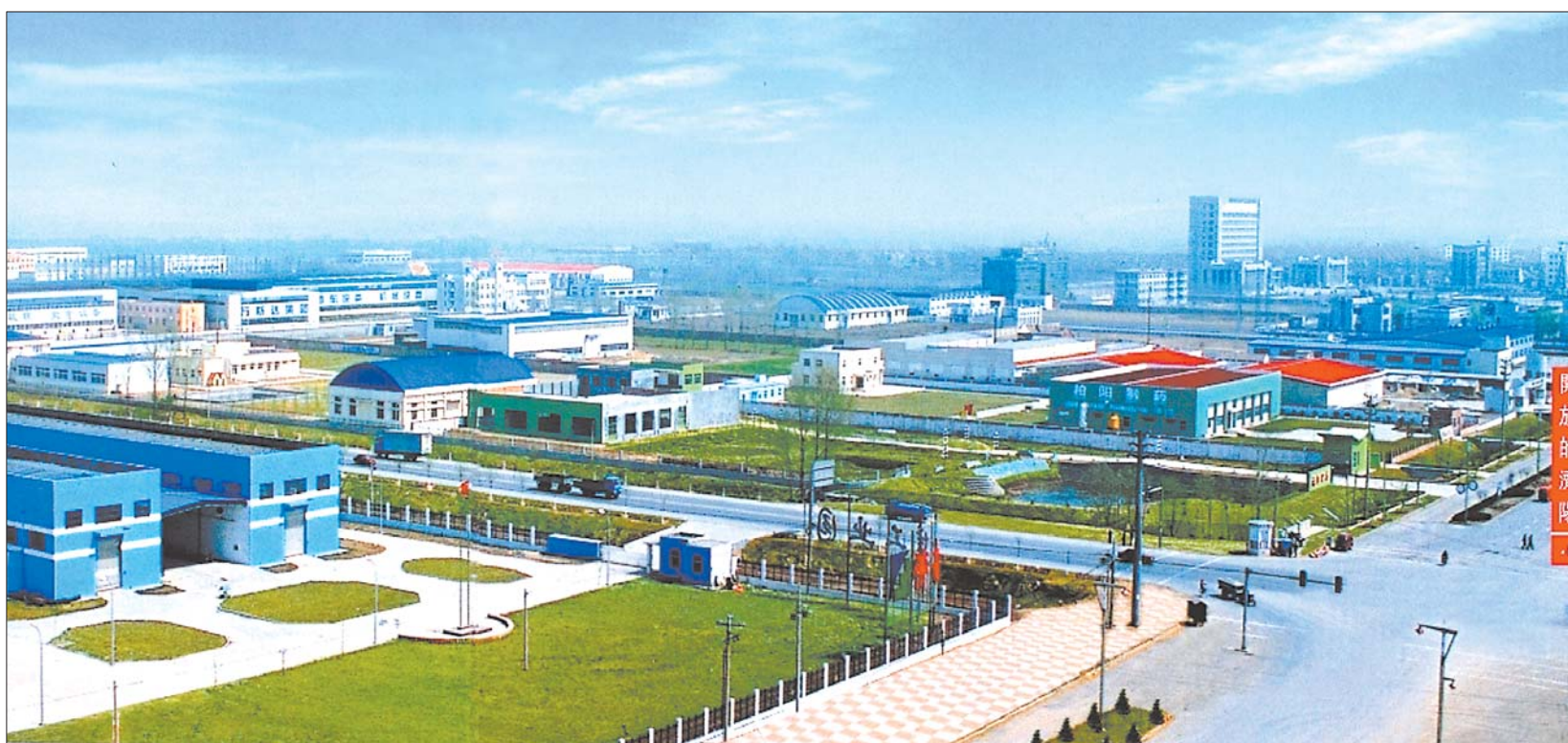
蒸蒸日上的济北开发区。
