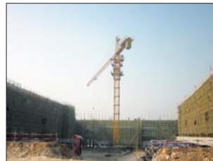
正在建设中的诺德实验小学。
