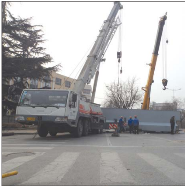
16日,青年路过街天桥开始主体吊装。 本报记者 侯峰 摄
