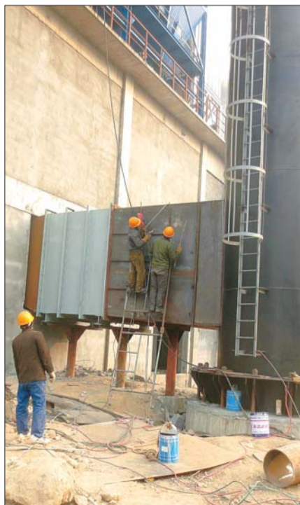
焦化厂烟气的余热回收项目施工现场。
