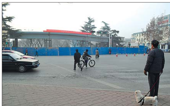
19日,青年路与岱宗大街路口的过街天桥主体钢架结构吊装工程基本完成。本报记者 侯峰 摄
