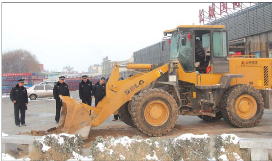
水泥底座被铲车清除。本报记者 张伟 摄
