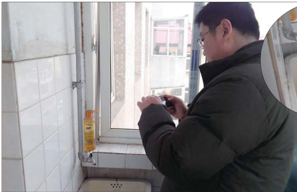
▲水龙头坏了,水池中一块海绵堵住了漏口。本报记者 苑菲菲 摄
