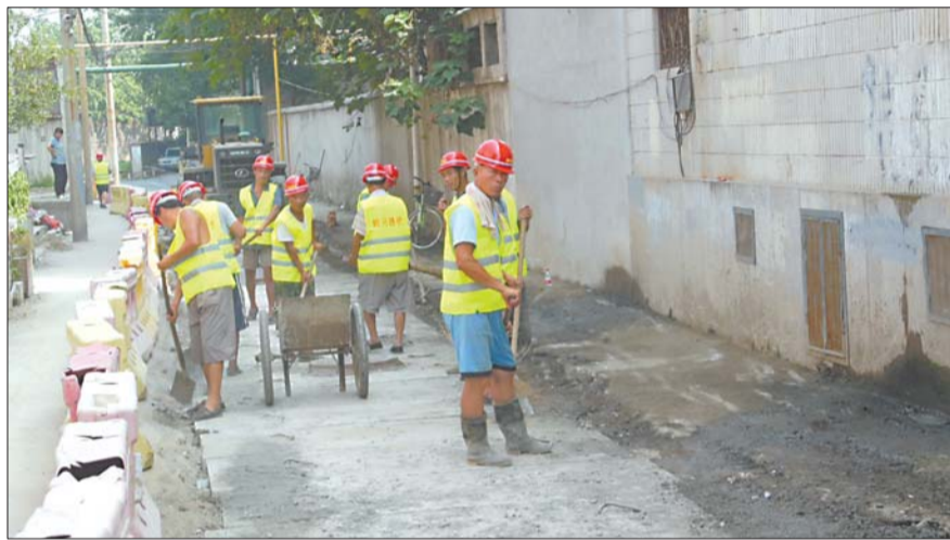
2013年8月,昆仑街小区正在进行雨污分流工程。记者 蒋龙 摄 (资料片)
