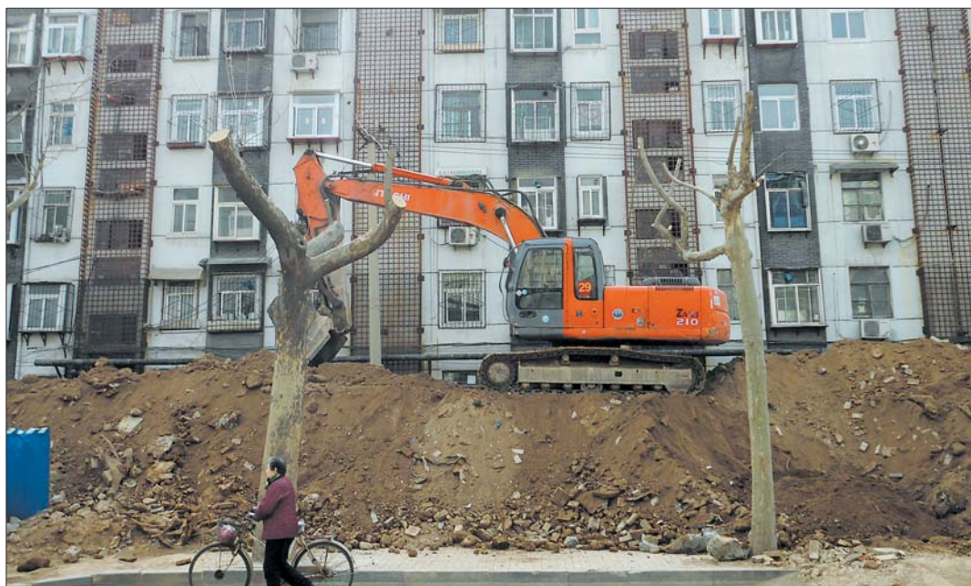
在和平路东段,施工方正在挖掘堆积土方。本报记者王光营摄
