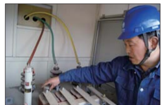
工作人员正在调节变压器分接开关。
