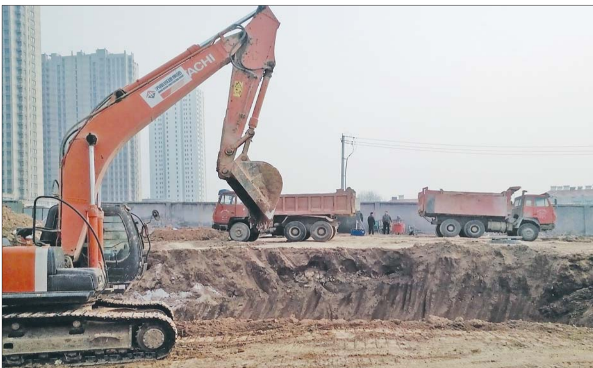
二环南路高架文庄片区施工现场,迁建工作已基本结束,大部分施工区已进行了地面夯实工作。 本报记者 刘雅菲 摄
