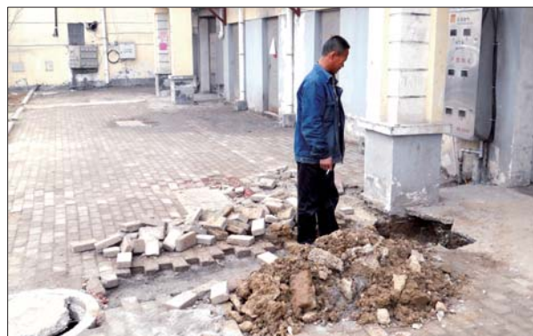
楼前管道已经被挖开。 本报记者 孟杰 摄
