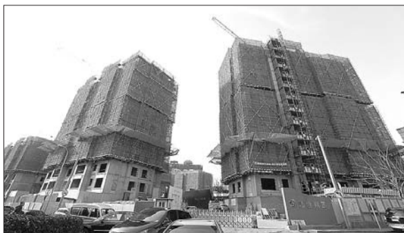
27日,青岛市南区一处楼盘正在建设。 本报记者 杨广帅 摄
