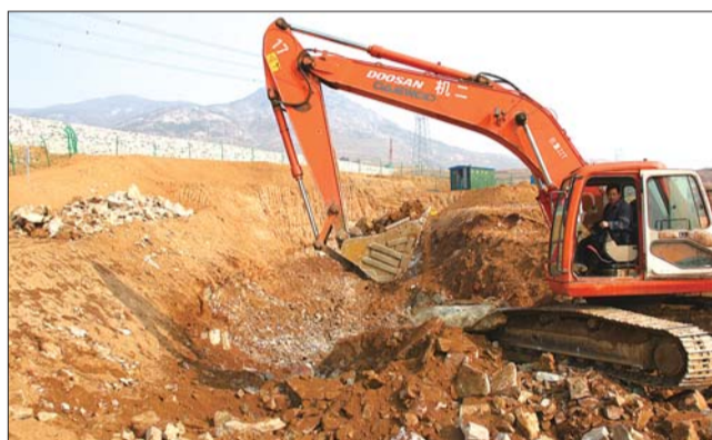
沐水东调施工现场。
